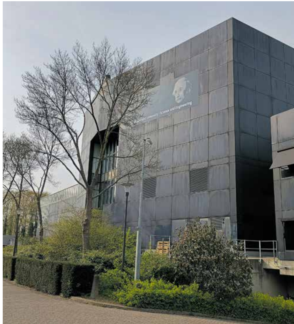
De zuidgevel van DUB30 wordt bekleed met zonnepanelen Foto: Observant
